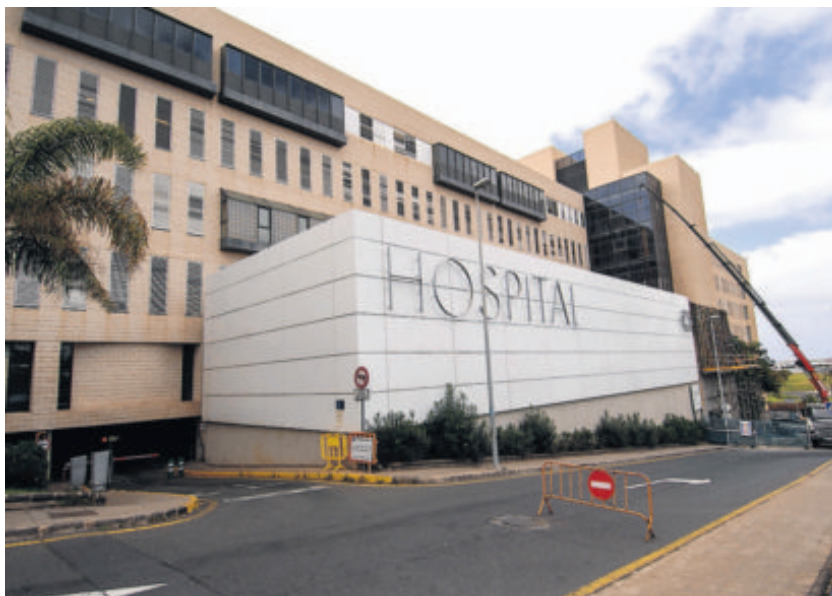
Obras del cuarto búnker del Doctor Negrín y futura ubicación del quinto, sobre la entrada del parking. | ANDRÉS CRUZ
